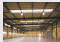
高天井倉庫照明 横浜海運様
